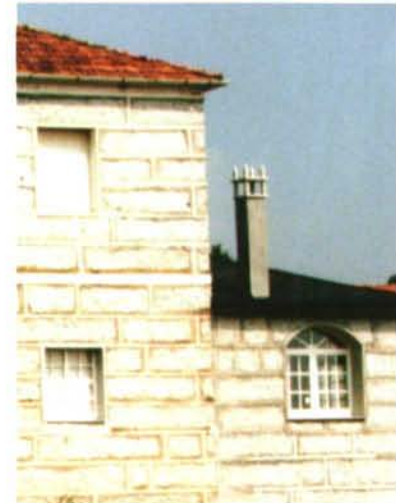
Casa en Tuiriz, Ferreira de Pantón. Foi ampliada, con materiais diferentes ós de orixe. Arriba, vista xeral; abaixo, por menor. Comprobamos variacións na cuberta, nas carpinterías e na fábrica.
