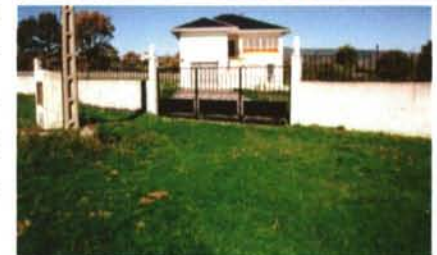
A falla de uso pode manifestarse en calquera fase da edificación. Nas imaxes, unha casa en Pena Folenche, Trives, con claros sinais de non ter sido ocupada en anos malia encontrarse totalmente rematada.
