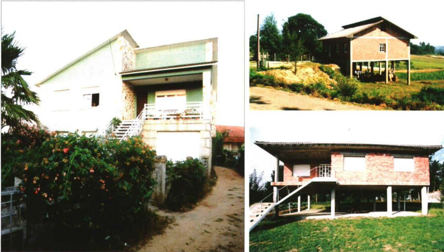
Casas de tipoloxía rupturista. De esquerda a a dereita e de arriba a abaixo, edificio en Adina, Sanxenxo; Castelo, Trazo e Corredoiras, Boimorto.
