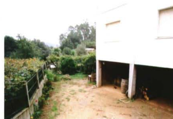
As funcións agrícolas, cando existen, son relegadas á planta terrea. Todo aquí -accesos, organización e mesmo os materiais de construción utilizados- adecúanse a este fin. Nas fotografías: edificio en Vilariño, Cambados.
