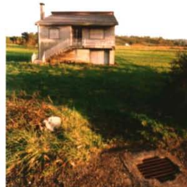
A chegada da auga encañada e do saneamento á casa rural posibilitará a instalación de cuartos de baño. Casa en Seavia, Coristanco.
