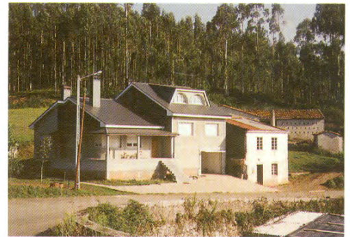
A casa contemporánea presenta sempre moito máis volume que a súa equivalente vernácula. No exemplo que se presenta nesta imaxe e dado que a vella casa non foi derrubada (como habitualmente ocorre cando se constrúe a nova) resulta posíbel comparar as escalas de ambas construcións. Edificio en Renda, Arzúa.
