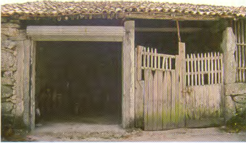
Os actores da construción executan as obras cos materiais que o mercado contemporáneo lle brinda pero coa tecnoloxía de sempre. Nas imaxes, dous detalles tomados de edificacións do ámbito rural do concello de Ferreira de Pantón.
