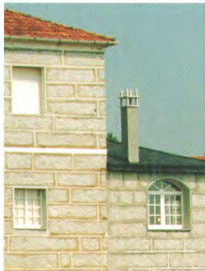
Casa en Tuiriz, Ferreira de Pantón. Foi ampliada, con materiais diferentes aos de orixe. Arriba, vista xeral; abaixo, pormenor. Comprobamos variacións na cuberta, nas carpinterías e na fábrica.
