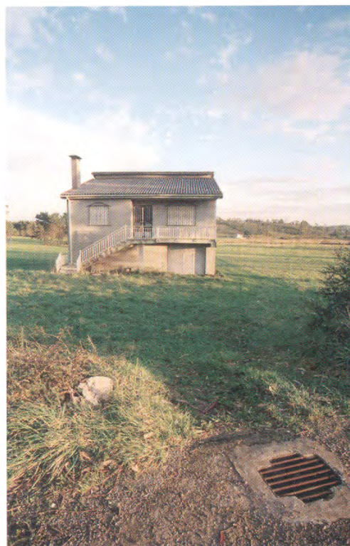
A chegada da auga encañada e do saneamento á casa rural posibilitará a instalación de cuartos de baño. Na imaxe: casa en Seavia, Coristanco.
