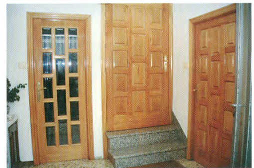
O illamento da escaleira nun local propio é unha solución amplamente estendida na casa rural contemporánea. Un efecto secundario é a aparición do portal. Nas fotos: portais e escaleiras interiores en vivendas da Peroxa, Coles; As Pontes, vila e San Amaro, vila.
