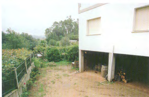
As funcións agrícolas, cando existen, son relegadas á planta terrea. Todo aquí –accesos, organización e mesmo os materiais de construción utilizados– adecúanse a este fin. Nas fotografías: edificio en Vilaríño, Cambados.
