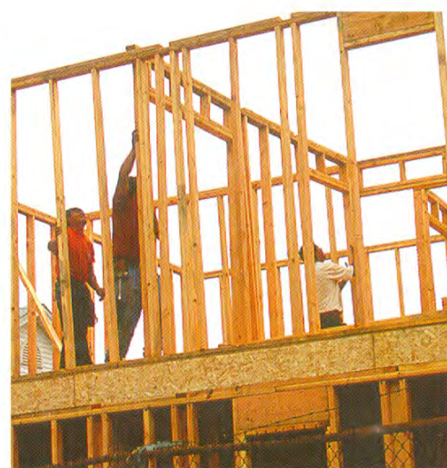
Grupo de emigrados galegos –orixinais de Muros e Carnota– traballando na construción (totalmente industrializada) dunha casa en Newark, New Jersey, EE. UU. Abril de 1996.
