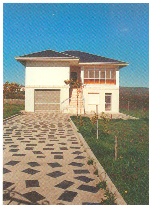
A falta de uso pode manifestarse en calquera fase da edificación. Nas imaxes, unha casa en Pena Folenche, Trives, con claros sinais de non ter sido ocupada en anos malia encontrarse totalmente rematada.
