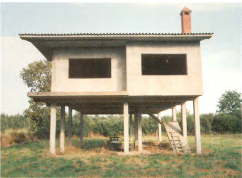
A estrutura porticada permite a apertura de ocos en fachada de moi diversa forma e dimensión e mesmo a liberación da planta. Esta circunstancia é particularmente apreciada polo construtor da casa rupturista. Arriba, casa en Vilariño, Cambados; no centro, outra en San Xusto, Coristanco e abaixo a outra en Foxados, Curtis.
